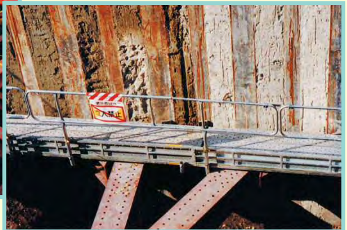
手摺にラージテッスル1-A型を使用
