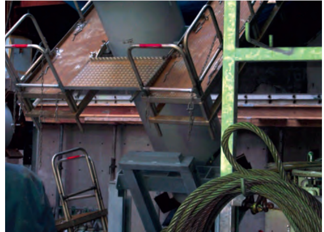
②回転止めピンを抜いて柱を立ち上げて行く。
