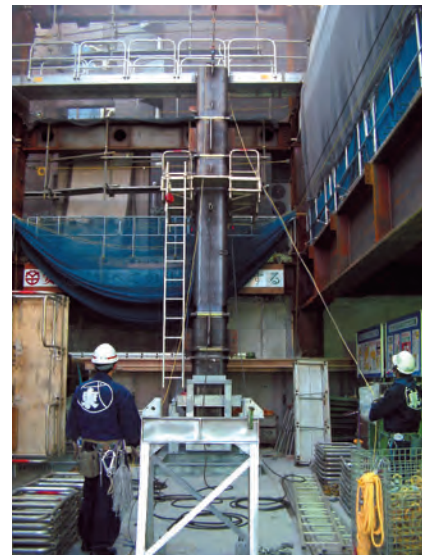
⑤この状態で回転止めピンを入れベルトを外し柱を外す。
