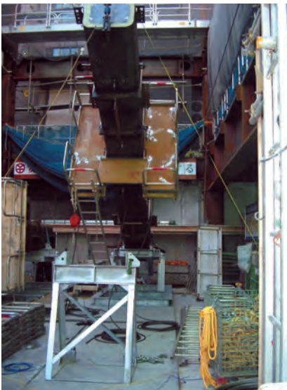
③クレーンにて柱上部を吊り上げて、柱を起こして行く。
