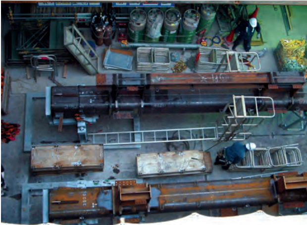
①コラムステージ並びにはしごを地組みでセットする。
