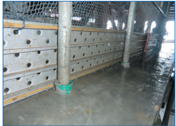
コンクリート打設後
