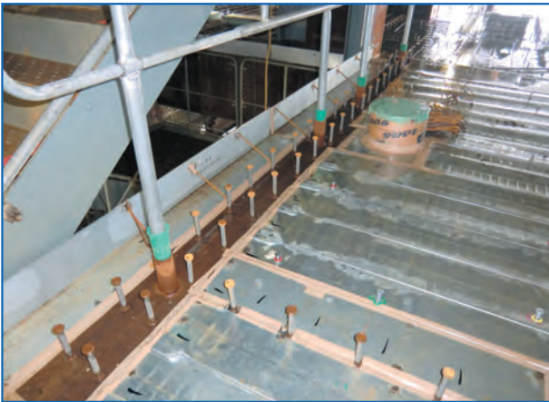
コンクリート打設前
