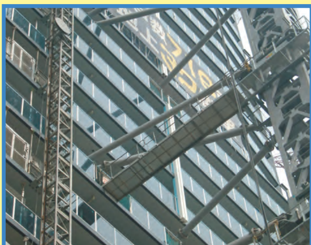
タワークレーン渡り通路
