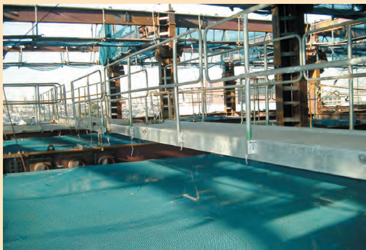
鉄骨上安全通路
