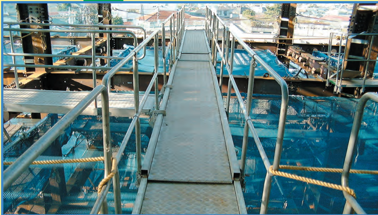
鉄骨上安全通路
